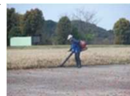
<射撃場鉛回収作業>
