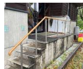
<階段手摺り新設>
