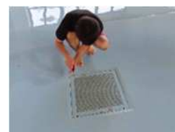
<プール排水口蓋点検>
