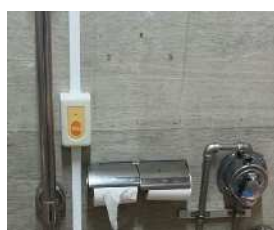
<トイレ呼出増設>
