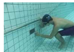
<プール排水口蓋点検>
