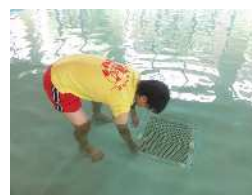
<プール排水口蓋点検>
