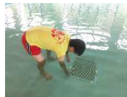
<プール排水口蓋点検>
